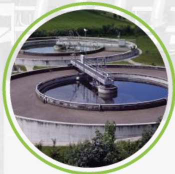
Čističky odpadních vod
